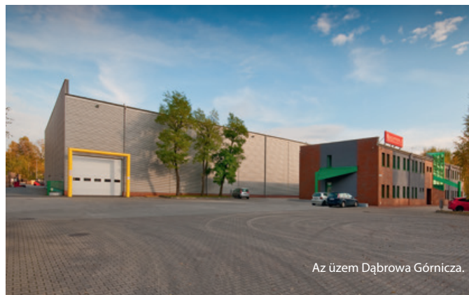
A BLACHPROFIL 2® gyártó és logisztikai központja Lengyelországban. Grojec – Krakkótól 20 km-re nyugatra (A4 Katowice–Krakkó autópálya).
