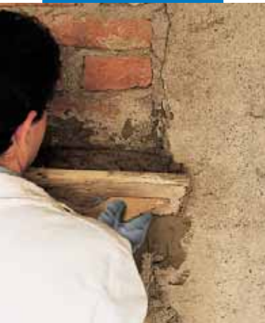
Régi téglafalazat helyreállítása
