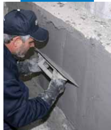
A Nivoplan bedolgozása simítóval
