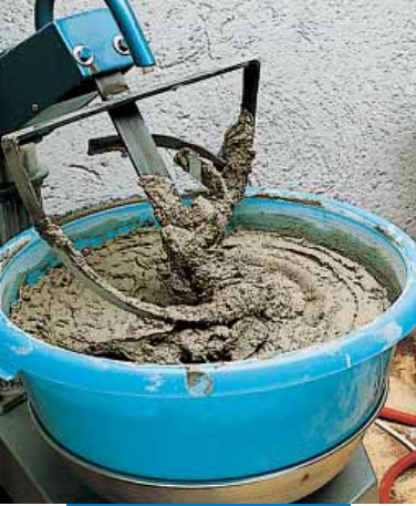
Bekeverés mini betonkeverővel
