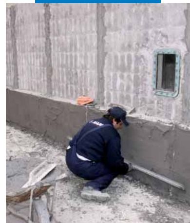
A vakolat lehúzása vakolóléccel
